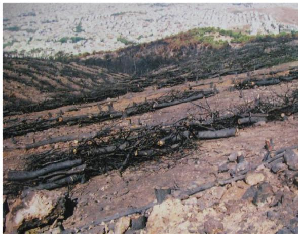
**Figura 6.7** Detalle de las barreras de troncos construidas inmediatamente después del incendio en Kareas (mostrado en Figura 6) foto tomada inmediatamente después de su construcción.
