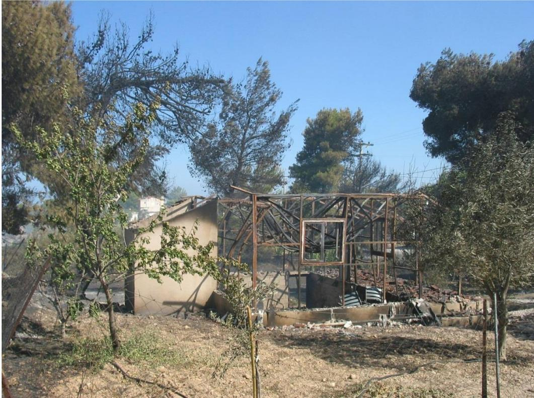
**Figura 7.1.18** Casa de muy baja calidad en Agia Triada que se quemó completamente. La vegetación verde que ha permanecido muestra que este punto no sufrió el ataque de un incendio masivo (G. Xanthopoulos)
