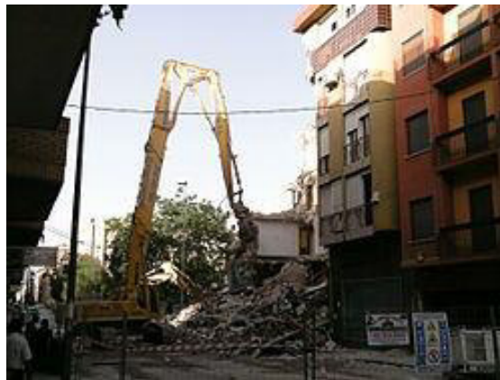
Figura 7.4.4 Demolizione di un edificio a Santa Fe Jerome, una scena comune nei mesi successivi al terremoto ( https://commons.wikipedia.org )
