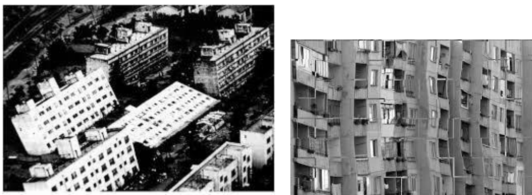
Figura 2.2.3.6 Danni da terremoto ( http://elearn.uni-sofia.bg/ )
