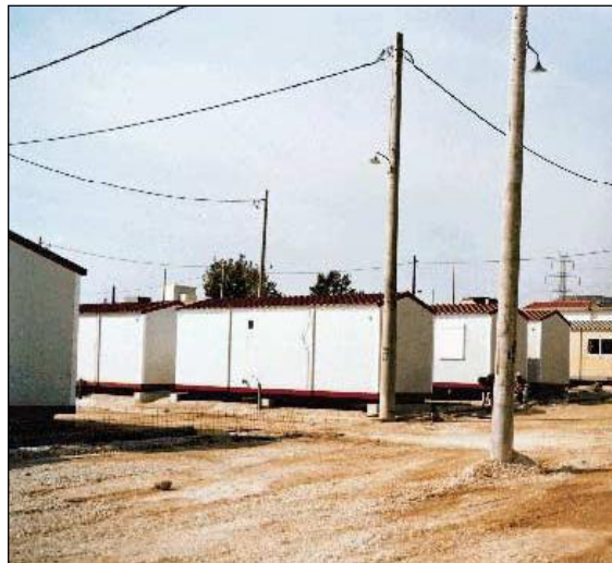
Figura 6.2 Insediamento provvisorio nella regione Attica (ECPFE, 2000)
