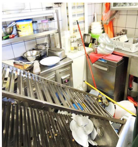
Figura 7.1.12 Danni non strutturali: mancanza di protezione antisismica per gli scaffali mobili, mancanza di sistemi di bloccaggio delle merci sulle scaffalature, sicure per controsoffitti e lampadari (GEER/EERI/ATC).
