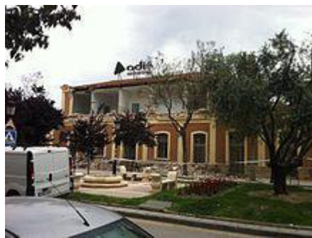
Figura 7.4.2 Stazione ferroviaria di Lorca, danneggiata dopo il terremoto di Lorca ( https://commons.wikipedia.org )
