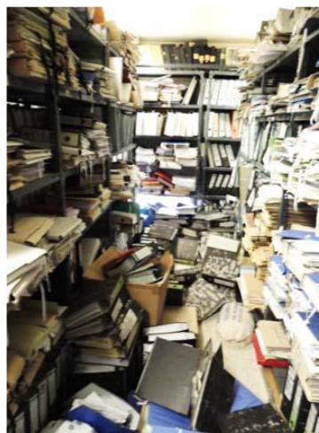
Figura 7.1.12 Danni non strutturali: mancanza di protezione antisismica per gli scaffali mobili, mancanza di sistemi di bloccaggio delle merci sulle scaffalature, sicure per controsoffitti e lampadari (GEER/EERI/ATC).
