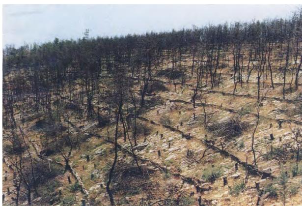
**Figura 6.9** Barriere di tronchi lungo i margini, costruite entro i 3 mesi successive all'incendio del 21 luglio 1995, sul pendio di Agios Petros, un sito a monte della città di Nea Makri sul monte Penteli, e est di Atene (G, Xanthopoulos)
