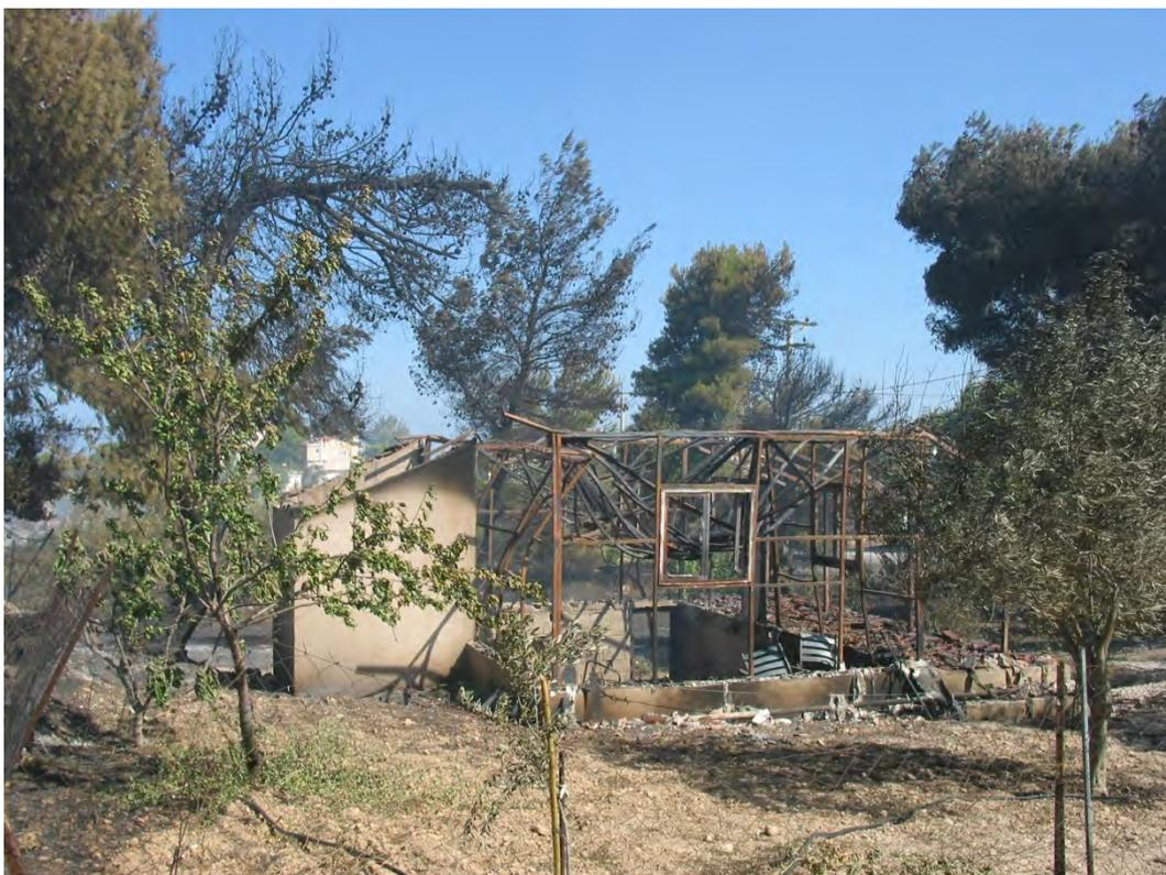
**Figura 7.1.18** Una delle case di bassissima qualità ad Agia Triada, bruciata completamente. La vegetazione verde rimasta intorno alla casa dimostra che questa zona non è stata interessata da un fuoco intenso (G. Xanthopoulos)
