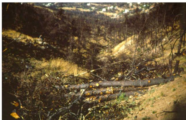
**Figura 6.10** Una briglia costruita con tronchi in un impluvio sul monte Penteli, entro 3 mesi dall'incendio del 1995 (G, Xanthopoulos)
