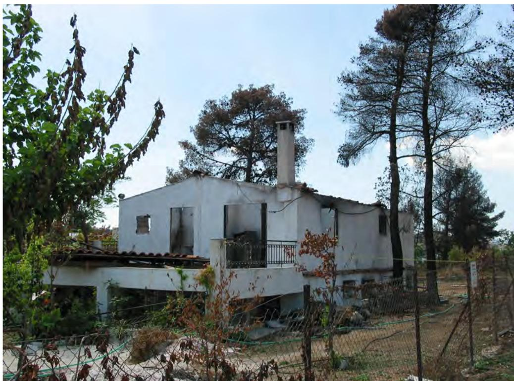
**Figura 7.1.19** Una delle case bruciate a Skoufeika. La fonte di calore sono state le due chiole che hanno preso fuoco vicino al tetto (G. Xanthopoulos)
