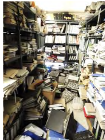
Фиг. 7.1.12 Неструктурни повреди: Липса на сеизмична защита на подвижните стелажи в ресторант, липса на ограничители на рафтовете и лошо закрепване за тавана на плочки и осветителни тела (GEER / EERI / ATC).
