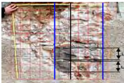
Фиг. 7.2.15 Стандартна оценка на ефективността на връзката между перпендикулярни стени. Премахването на мазилка отне 20 минути.
