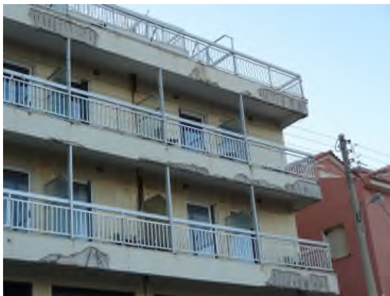
Фиг. 5.3 Повредена сграда след земетресението в Кефалония, Гърция през 2014 г. (EPPO)
