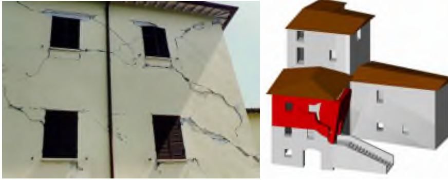
Фиг. 7.2.3 ова е зидана сграда с укрепващ пръстен от стоманобетонни греди. В този случай можем да видим колко важно е да се постигне добра връзка между новия стоманобетонен пръстен и съществуващата зидария.
