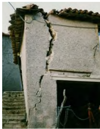
Фиг. 7.2.4 При тази зидана сграда е възможно да се види преобръщането на стената, причинено от лоша връзка на покрива със стената.
