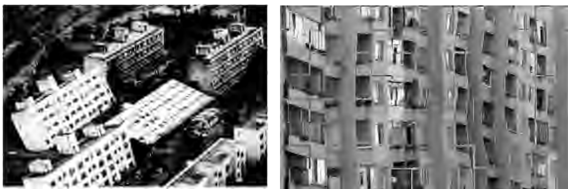
Фиг. 2.2.3.6 Разрушения след земетресение ( http://elearn.uni-sofia.bg/ )
