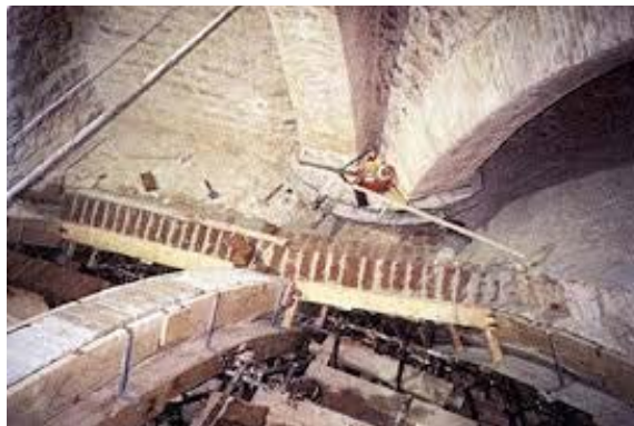
Fig. 1.2.2.-2: The reinforcement of the vaults in the Basilica of Assisi (Provincia di Perugia and Servizio Sismico Nazionale, 1998)
