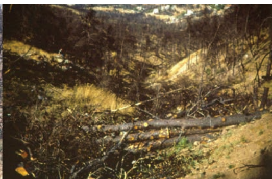
Εικόνα 6.10 Ένα ξυλόφραγμα αναχαίτισης που κατασκευάστηκε από κορμούς δέντρων σε μια ρεματιά στο βουνό της Πεντέλης, εντός 3 μηνών μετά την πυρκαγιά του 1995 (Γ. Ξανθόπουλος)
