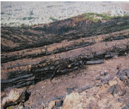
Εικόνα 6.7 Λεπτομέρεια από τα εμπόδια κορμών που κατασκευάστηκαν αμέσως μετά την πυρκαγιά του Καρέα (σχήμα 6)
