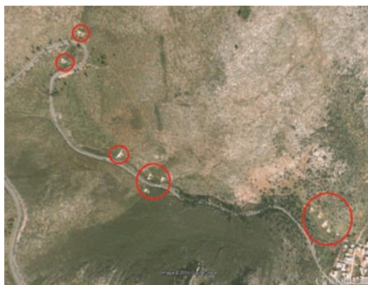
Εικόνα 6.11 Μια σειρά φραγμάτων αναχαίτισης από σκυρόδεμα χτισμένα ανάντη της περιοχής της Νέας Μάκρης, λίγους μήνες μετά την πυρκαγιά της Πεντέλης 1995 (Google Earth εικόνα 2004)
