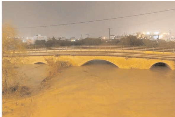
Εικ.7.1.6: Φωτογραφίες από την πλημμύρα του Ιανουαρίου του 2015 στον Γιόφυρο. (Πηγή: www.cretalive.gr )
