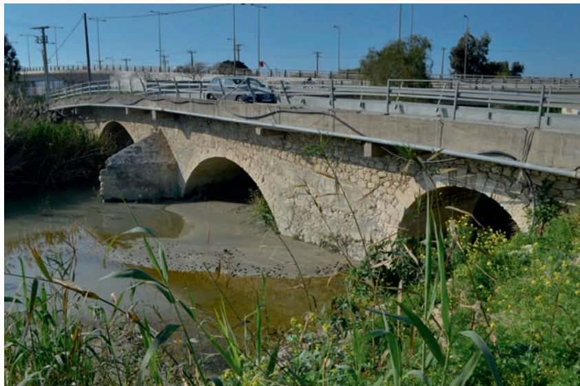
Εικ.7.1.4: Μια παλιά πέτρινη γέφυρα στον κόμβο του Γιόφυρου. (Πηγή: ΜΦΙΚ)
