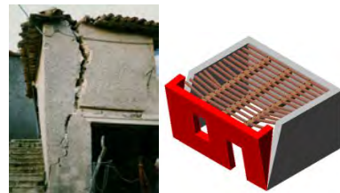
Εικ. 7.2.4 Κτίριο από φέρουσα τοιχοποιία με διαζώματα από σπλισμένο σκυρόδεμα
