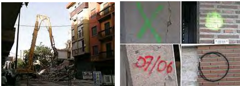
Εικ. 7.4.5 Κατεδάφιση κτιρίου στην Santa Fe Jerome ( https://commons.wikipedia.org )
