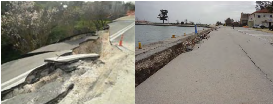
Εικ. 7.1.5 Βλάβες στο οδικό δίκτυο Ληξουρίου – Χαβριάτων (Πηγή: Ο.Α.Σ.Π. 2014)
