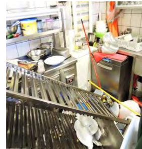
Εικ 7.1.12. Μη δομικές βλάβες (Πηγή: GEER/EERI/ATC).
