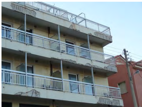
Εικ. 5.3 Κτίριο με βλάβες από τον σεισμό στη Κεφαλονιά, το 2014 (Πηγή: Ο.Α.Σ.Π.)
