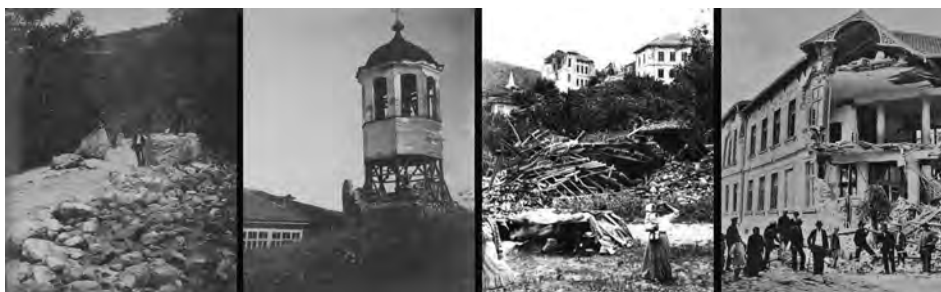
Εικ. 2.6 Υλικές ζημιές στη Gorna Oryahovitza μετά από τον σεισμό του 1913 (Πηγή: http://www.capital.bg/ )
