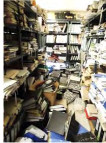
Εικ 7.1.12. Μη δομικές βλάβες (Πηγή: GEER/EERI/ATC).
