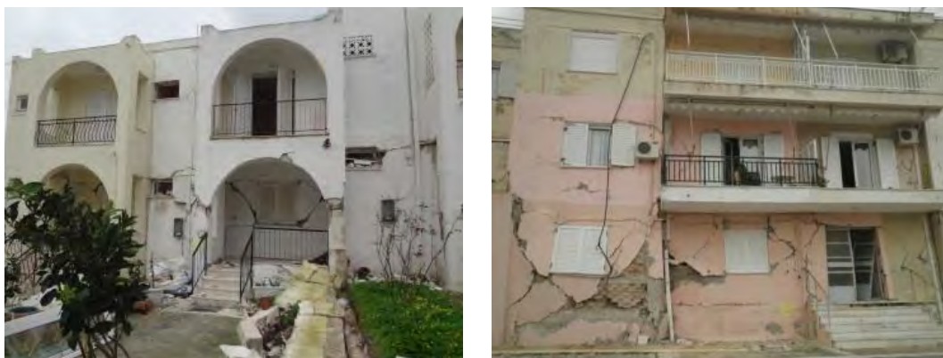
Εικ. 7.1.8. Συγκρότημα εργατικών κατοικιών στο Ληξούρι που υπέστη σοβαρές ζημιές (Πηγή: Ο.Α.Σ.Π. 2014)
